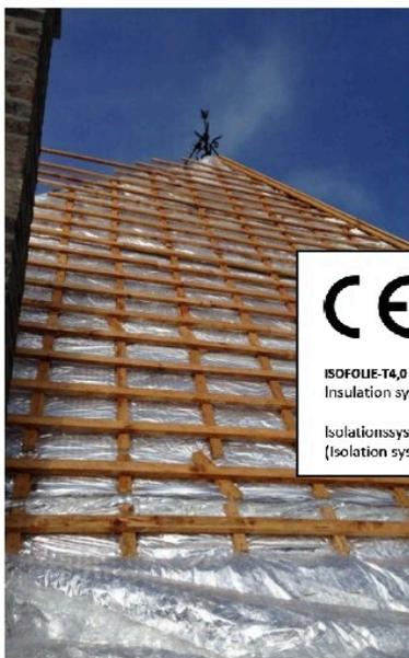
Durch die ISO FOLIE® werden schlanke Baukonstruktionen bei gleicher Dämmstoffleistung möglich. Die Berechnung der ISO FOLIE erfolgt nach DIN EN ISO 6946 mit der Energiebedarfsberechnungs-Software von Hottgenroth.
